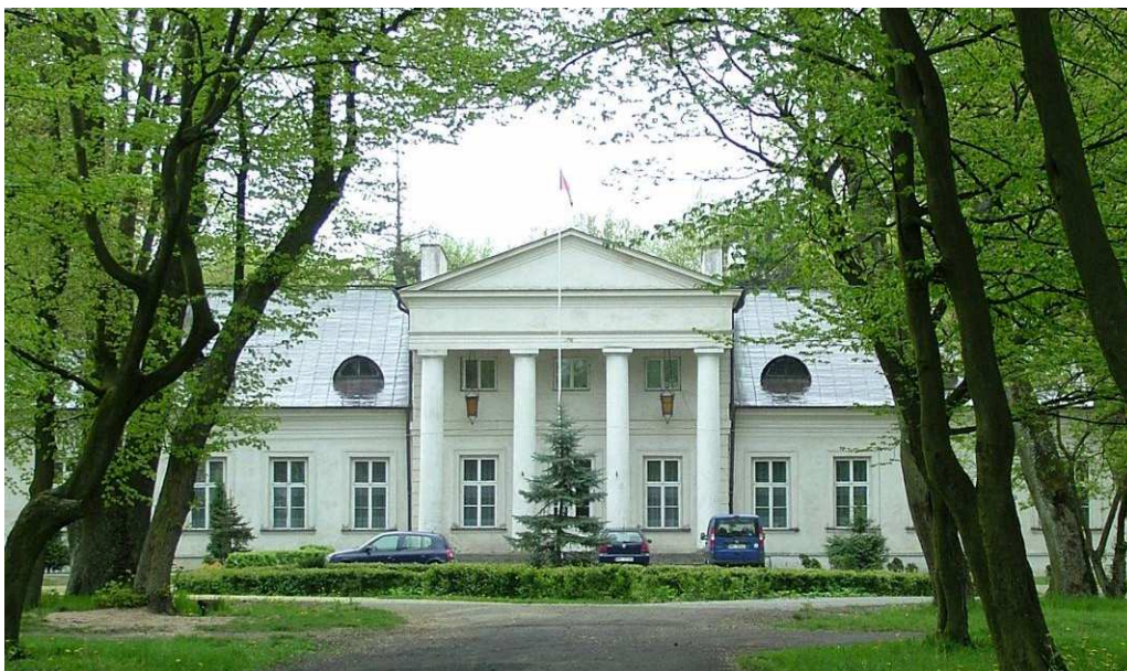
Pałac w Dębinkach
